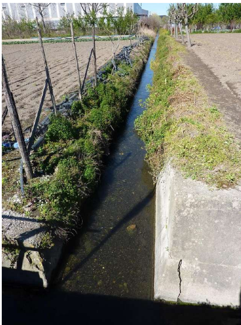
Figura 2-1: Canale delle Acque Alte Sarno
