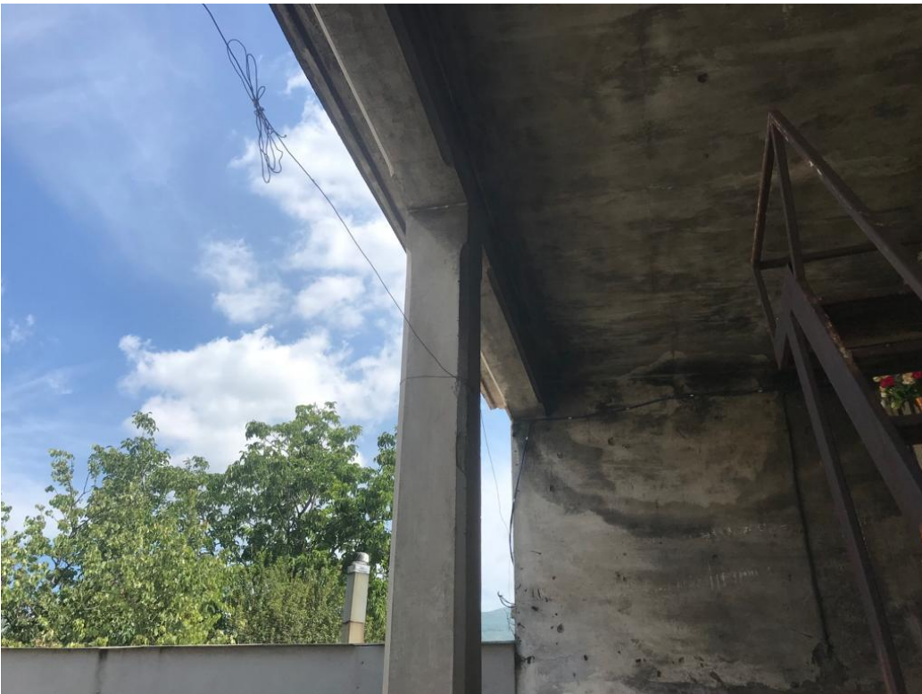
LOTTO 7 - Foto dello stato manutentivo della struttura
