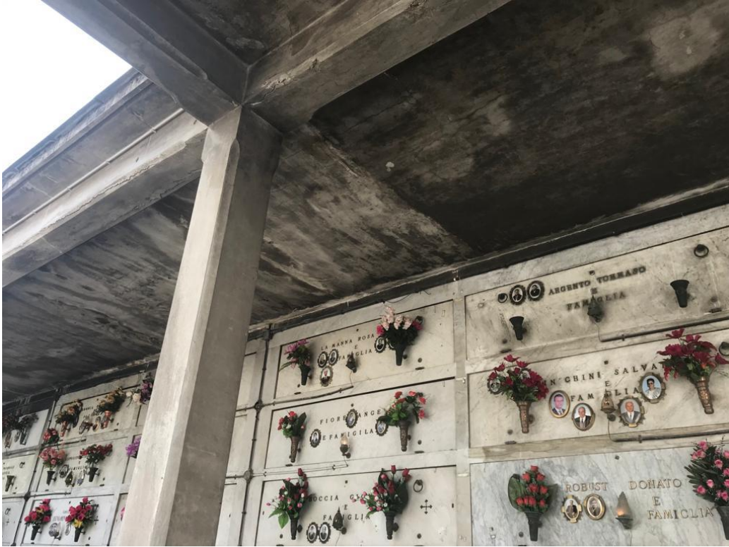
LOTTO 7 - Foto dello stato manutentivo della struttura
