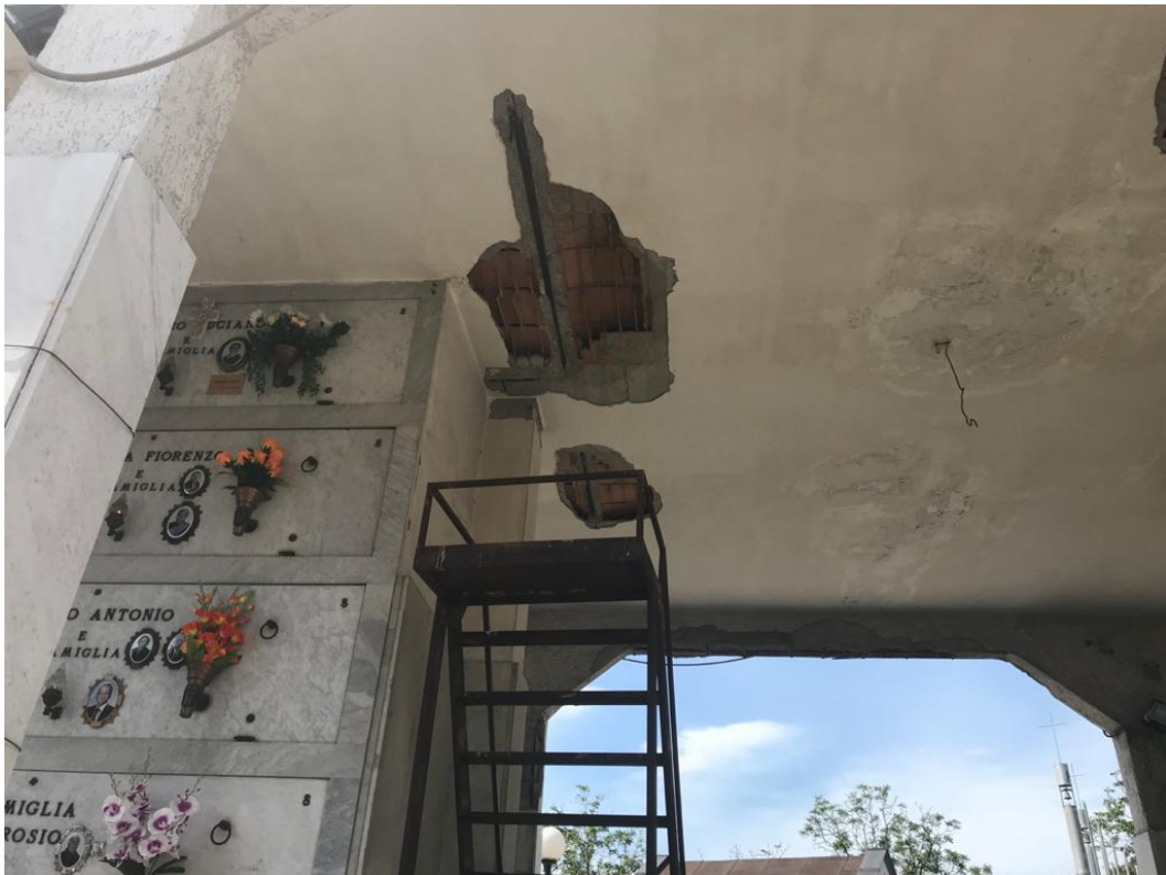
LOTTO 5 - Foto dello stato manutentivo della struttura
