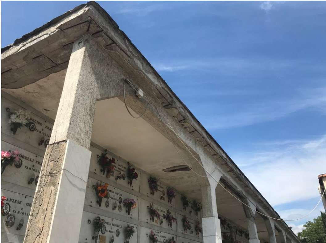
LOTTO 5 - Foto dello stato manutentivo della struttura
